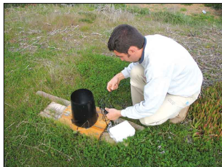
Figura 4. Instalación de registradores de pulsos
